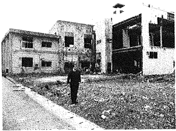
(津波で壊滅した建物・大槌町)
