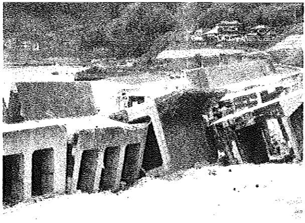
(津波で破壊された釜石市の防潮堤)
